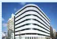
大阪中央データセンター
