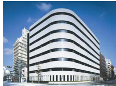
大阪中央データセンター
