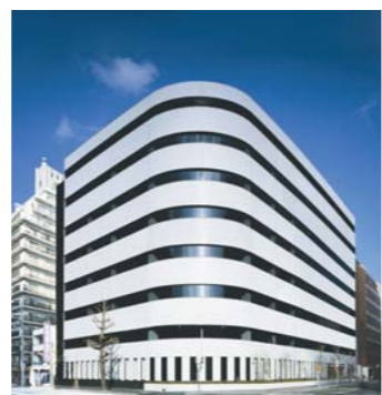
大阪中央データセンター
