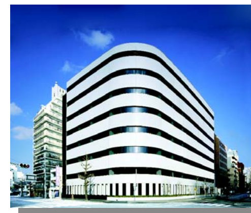
大阪中央データセンター
