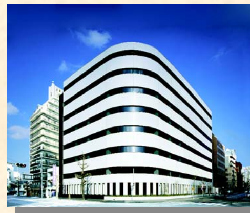
大阪中央データセンター
